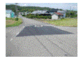
道路舗装復旧
