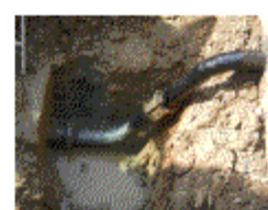
継ぎ手部補修
