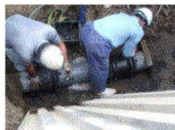
継ぎ手部補修
