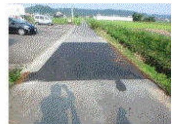
道路舗装復旧
