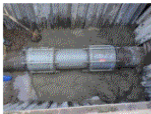
中山分線（八百津町地内） VM管350mm継手部の漏水補修
