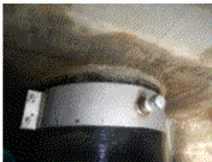
森山支線（新池町地内） 電食による鋼管600mm漏水補修
