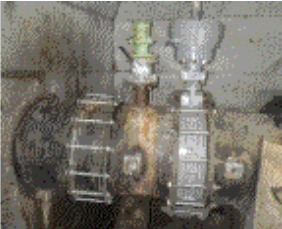
坂祝用水路（加茂野町地内） 制水弁600mm取替補修
