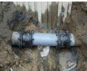
米田畑第2支線（下米田町地内） VP管250mm継手部の漏水補修
