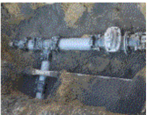
黒岩分線（加茂野町地内） VP管200mm継手部及び制水弁補修
