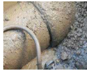
八百津西分線（八百津町地内） PC管500mm継手漏水補修
