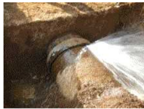
羽生用水路（蜂屋町地内） PC管600mm継手漏水補修
