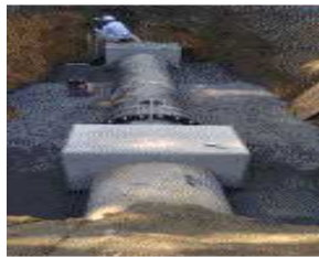
坂祝支線（坂祝町地内） FRPM管900mm継手漏水補修
