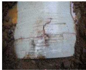
羽生支線（蜂屋町地内） FRPM管1000mm継手漏水補修
