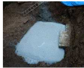
羽生支線（蜂屋町地内） FRPM管1000mm継手漏水補修
