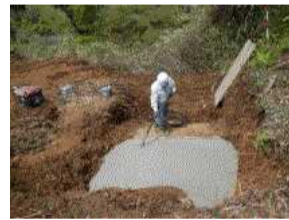
羽生用水路（蜂屋町地内） PC管600mm継手漏水補修
