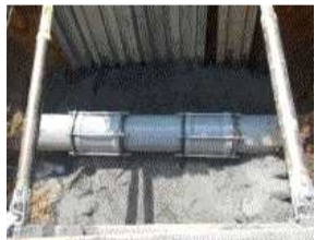
坂祝支線（坂祝町地内） FRPM管900mm継手漏水補修
