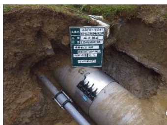
米田支線（下米田町地内） 漏水補修（外バンド取付）
