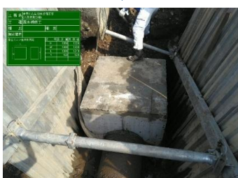
八百津東分線（八百津町地内） 漏水補修（コンクリート巻立て）
