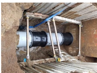
米田支線（下米田町地内） 漏水補修（FRP管取替え）
