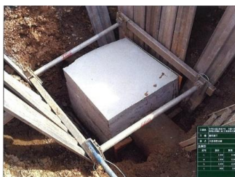
八百津西分線（八百津町地内） 漏水補修（コンクリート巻立て）
